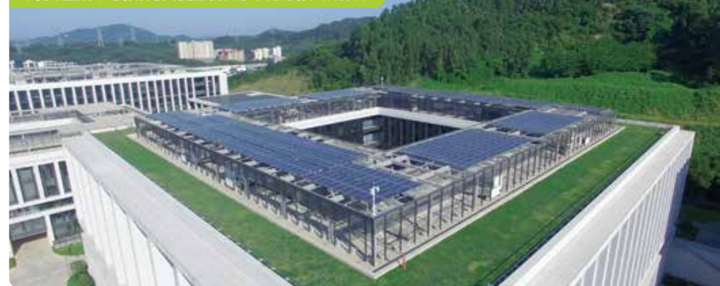
公司总部屋顶分布式光伏发电系统是国内最大的公共建筑光伏一体化项目
